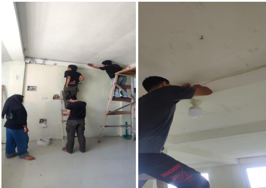
Gambar 2. Pemasangan Kabel dan Lampu dari sumber tegangan
