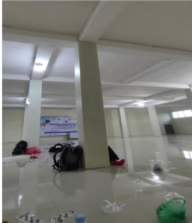
Gambar 3. Uji coba Instalasi Lampu terlihat menyala
