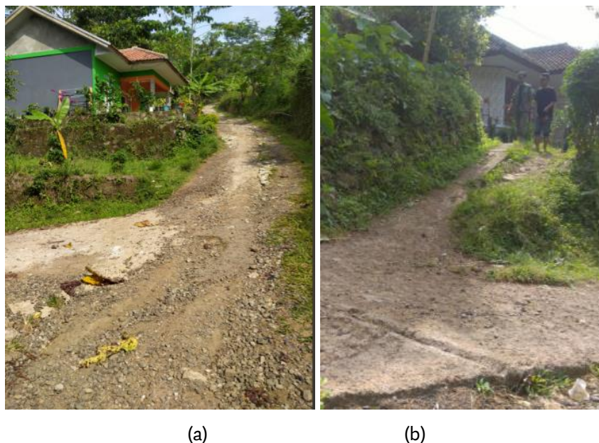
Gambar 2. Lokasi pemasangan lampu sel surya (a) di titik 2. (b) di titik 3
