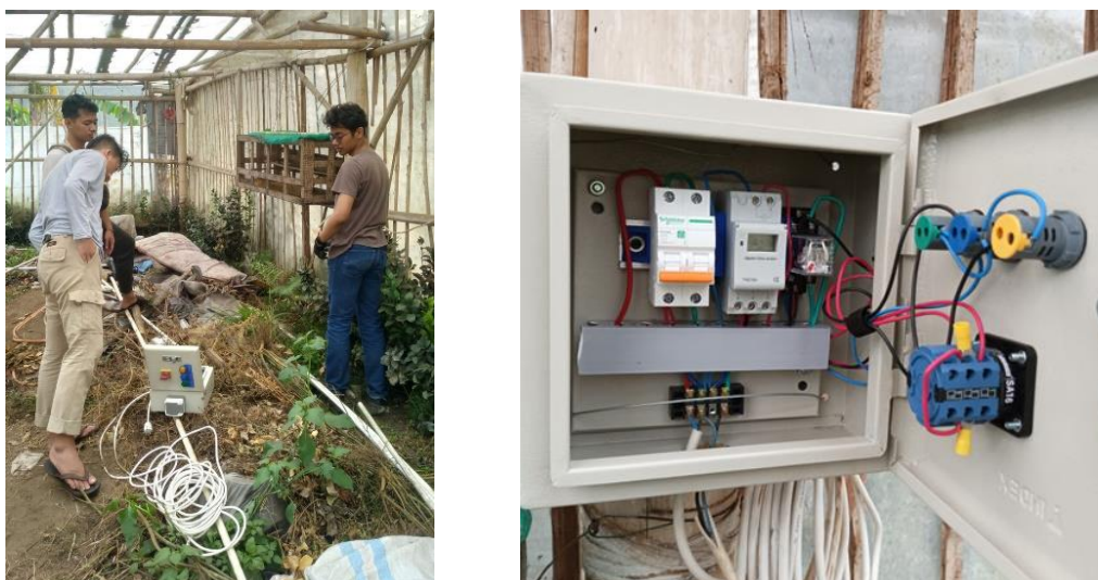
Gambar 6. Proses Pemasangan Sistem Kelistrikan dan Kontrol Panel yang Telah Terpasang
