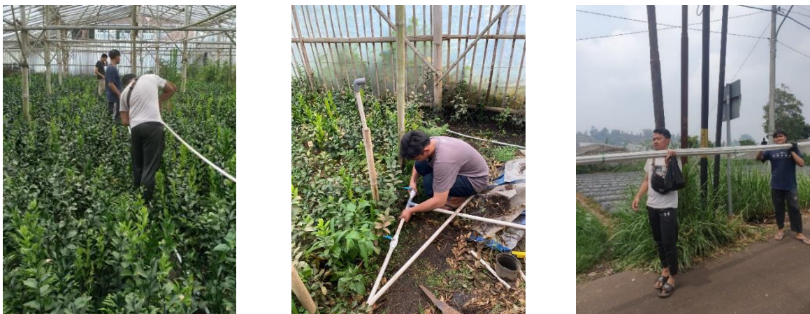
Gambar 8. Proses Pemasangan Sistem Perpipaan
