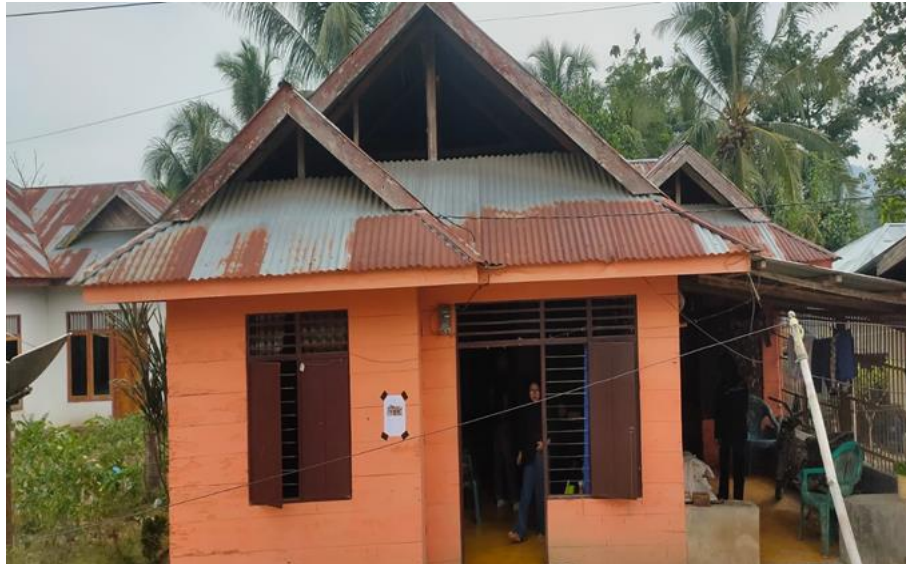
Gambar 3. Salah satu rumah yang dilakukan perbaikan instalasi.
