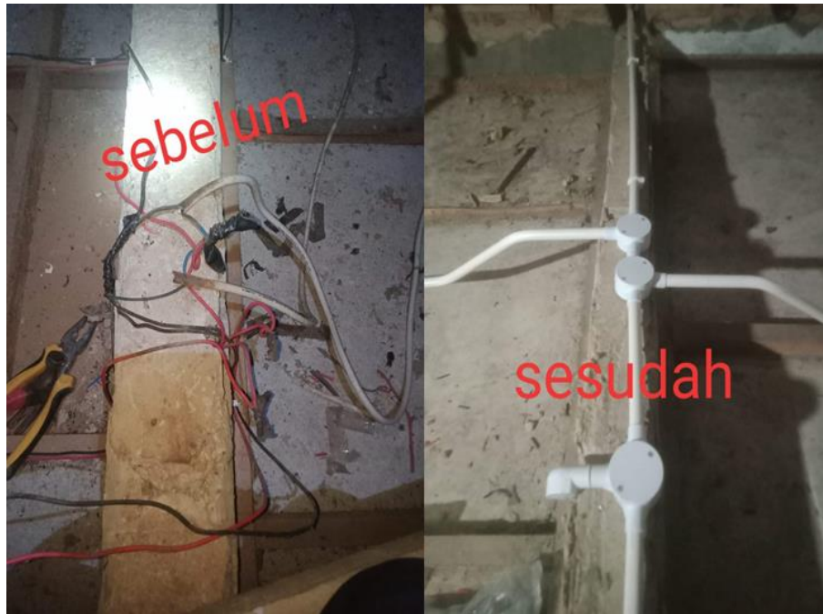
Gambar 5. Contoh sambungan setelah perbaikan
