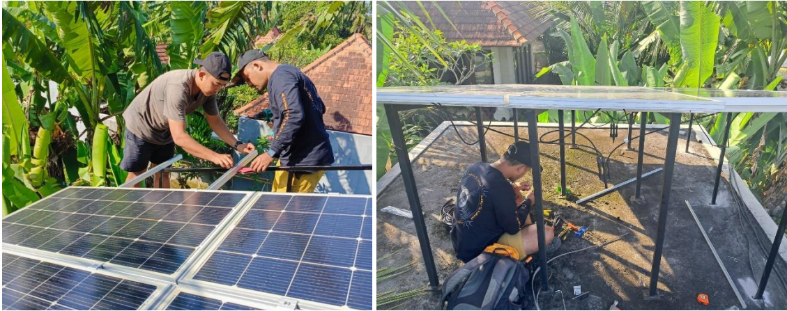
Gambar 4. Proses Pemasangan Panel Surya dan Pengukuran Tegangan Keluaran saat Peak Sun Hours (PSH)
